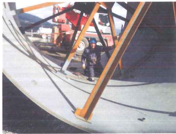
Figura 4 – Pré-Fabrico das Virolas da Blindagem da Galeria de Adução
