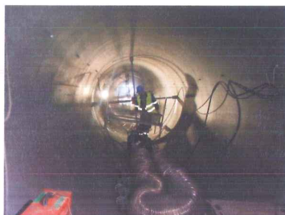
Figura 8 – Montagem da Descarga de Fundo
