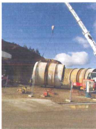
Figura 3 – Pré-Fabrico das Virolas da Blindagem da Galeria de Adução
