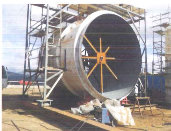
Figura 1 – Pré-Fabrico das Virolas da Blindagem da Galeria de Adução
