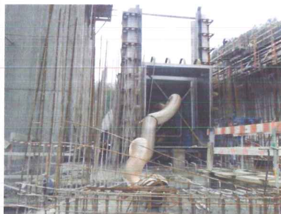
Figura 6 – Montagem da Descarga de Fundo
