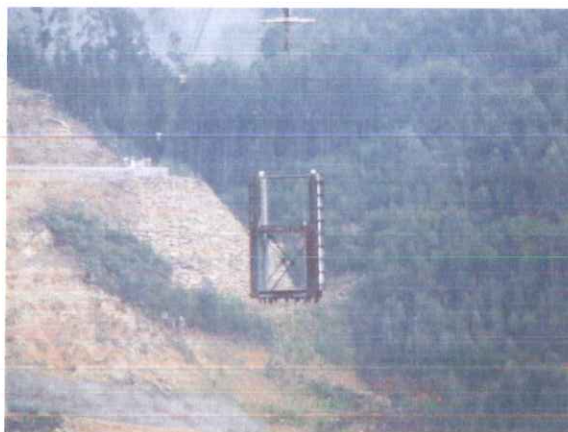
Figura 5 – Montagem da Descarga de Fundo
