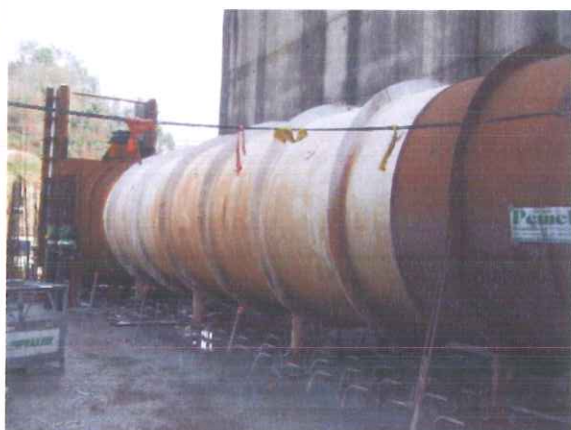
Figura 7 – Montagem da Descarga de Fundo
