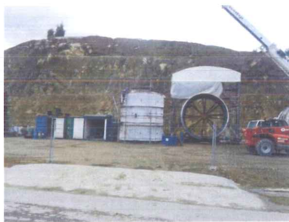
Figura 2 – Pré-Fabrico das Virolas da Blindagem da Galeria de Adução
